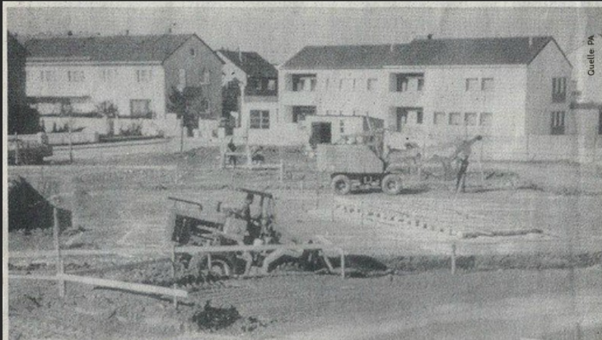
Das war der Anfang der Pfarrei St. Michael in Plattling. Am 17. Oktober 1969 begannen die Baumaschinen mit den Erdaushubarbeiten im Stadtwesten. Auf dem Gelände sollte die neue Pfarrkirche mit Pfarramt entstehen.
